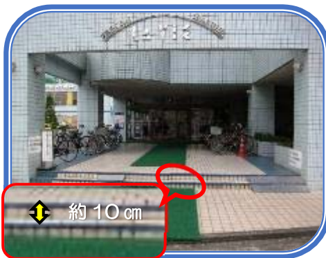
正面玄関出入口
